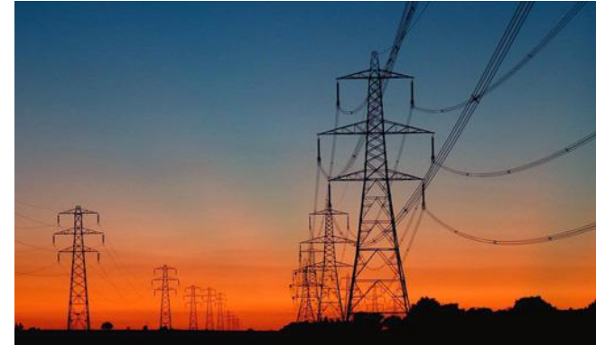
Figura 1. Redes de distribución eléctrica.
